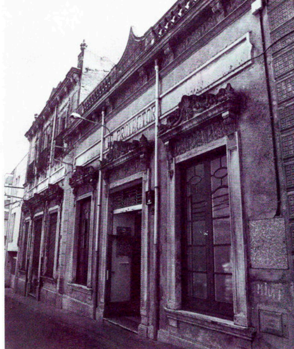
Estat actual de la cooperativa de consum "La Protectora".
